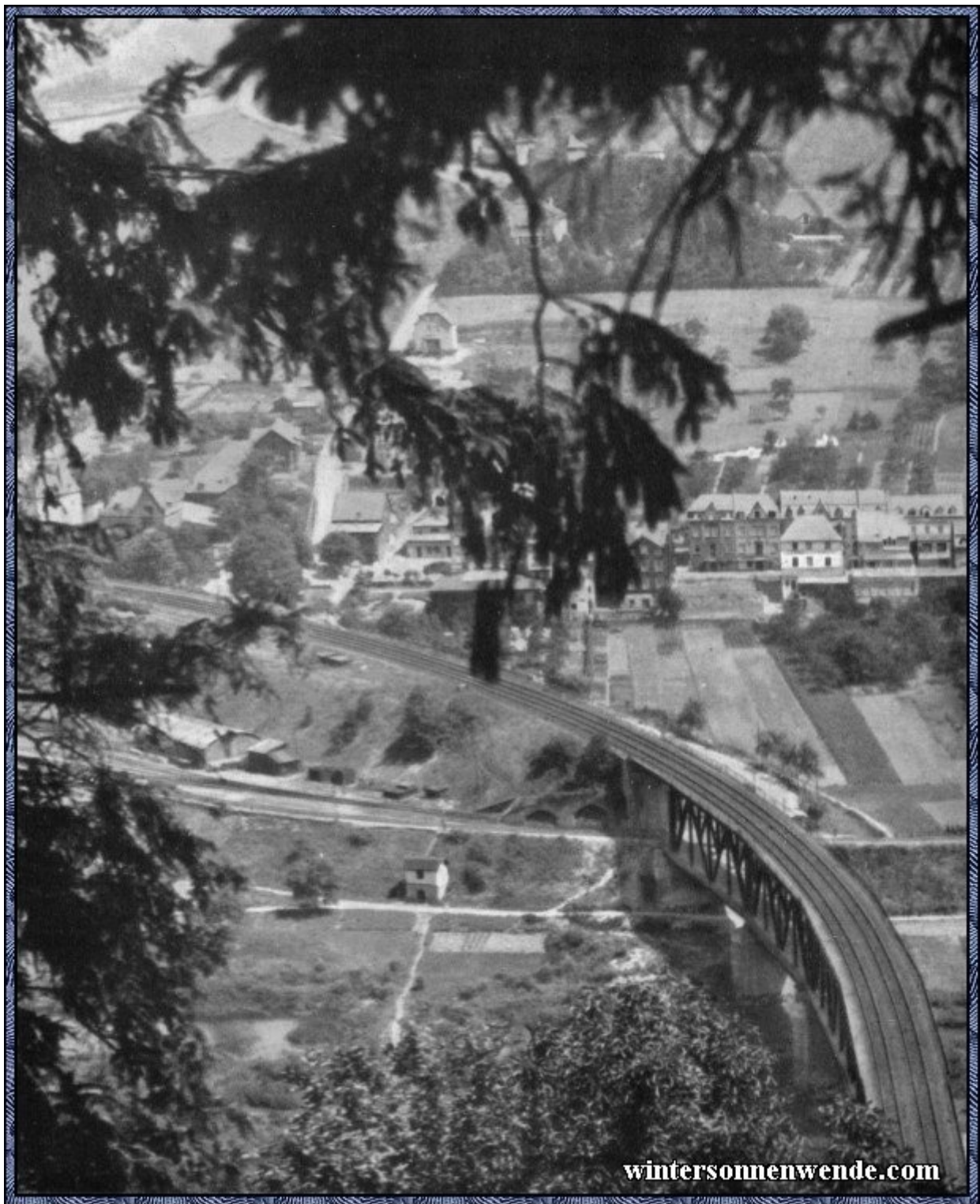
Eisenbahnviadukt im Moseltal.
